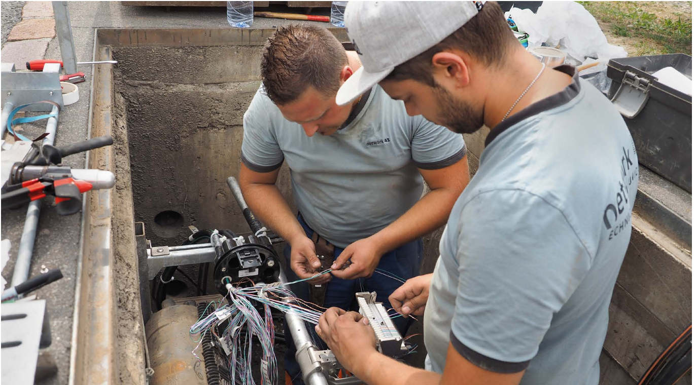
Kupferspleissung im Schacht
