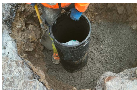
Beim Bau des Antennenschachtes
