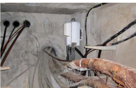
Mobilfunkequipment zum Antennenschacht
