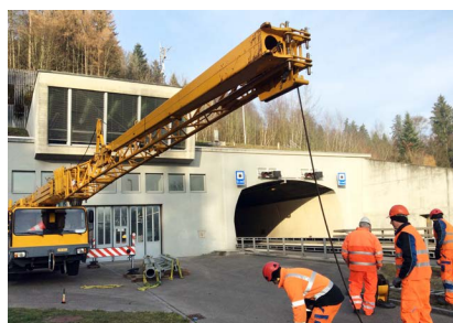
Mastenstellen beim Baregg-Tunnel
