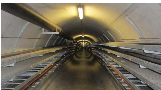
Deckenmontage Strahlungskabel im Werkleitungsstollen
