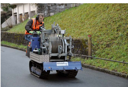
Kabeleinzug mit der Kabelzugmaschine
