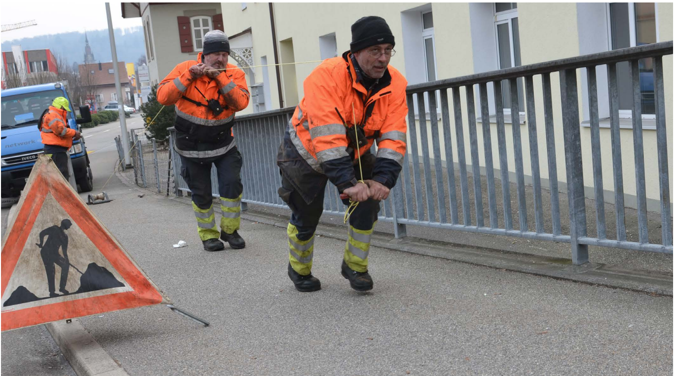
Network 41 beim Ziehen der Kabel
