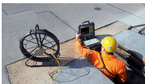
Sondierung der bestehenden Rohranlage mit Kamerarute
